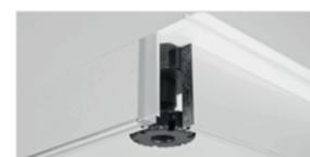
Die eingefräste und eingeklebte Sockeldichtungsleiste zusammen mit dem Justierbein sind ein Beispiel verdeckter Funktionsdetails, die für die lange Lebensdauer einer Küche notwendig sind.
